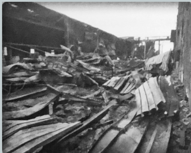
ФОТО 10 Склад зруйнований ракетою
